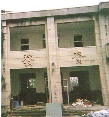
社辦大本營所在的舊北樓，目前正進行整修的工程。
